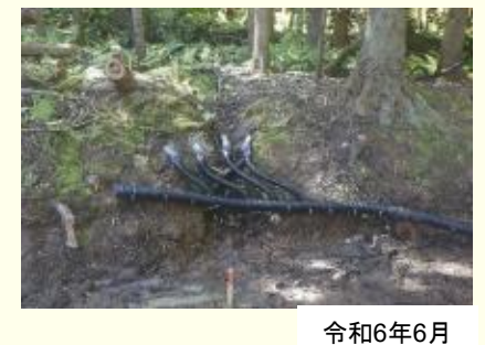
水抜きボーリング
