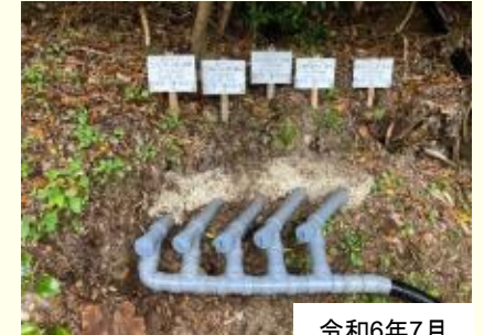
水抜きボーリング
