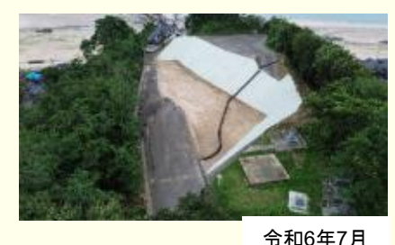
水抜きボーリング、頭部排土
