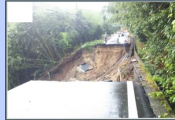
▲国道249号（石川県七尾市）道路崩落 ※損壊箇所へ車両3台の転落があり、病院へ搬送されましたが（うち2名軽傷、1名重傷（骨折）、全員命に別状はなく意識あり。
