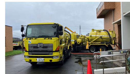
ポンプ車による排水
