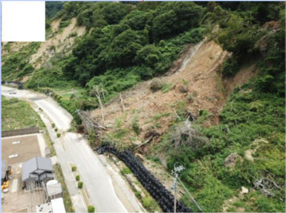
▲国道249号(石川県珠洲市)道路崩落
