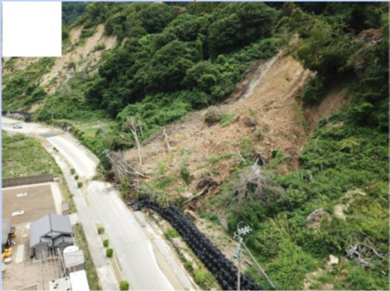
▲国道249号(石川県珠洲市)道路崩落
