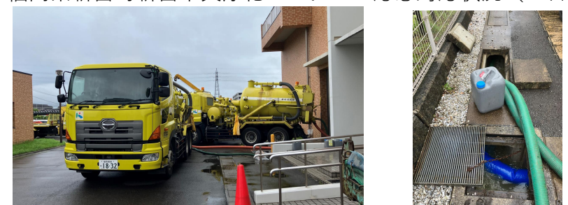
ポンプ車による排水
