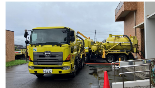
ポンプ車による排水
