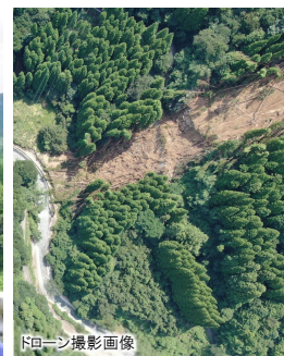
被災状況調査(ドローン) (熊本県甲佐町)
