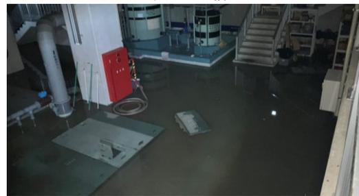
反応槽 (地下1F) の浸水状況
