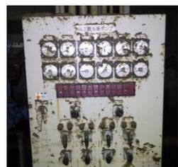
ポンプ制御盤 (地下2F) の被災状況
