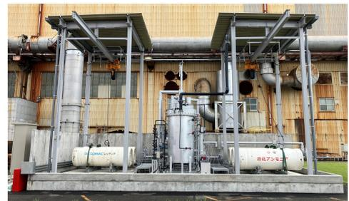
図3-2 アンモニア供給設備外観
