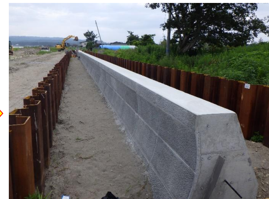
本復旧状況（護岸復旧）
