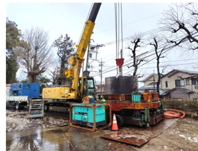
実証実験施工状況(金沢市)
