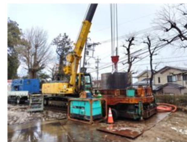
実証実験施工状況(金沢市)
