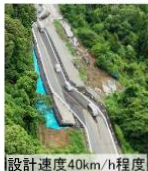
能越道での段階的な復旧イメージ
