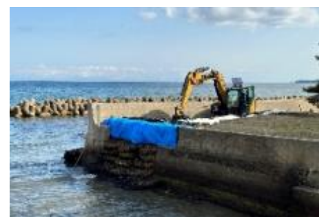
袋詰玉石、大型土のう敷設完了
