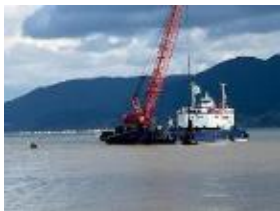
浚渫作業の状況 (R6.10)
