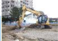
現地着工の状況 (R6.12)
