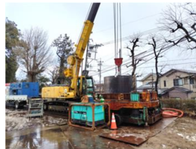
実証実験施工状況（金沢市）
