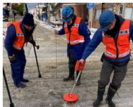
漏水調査(東京都水道局)
