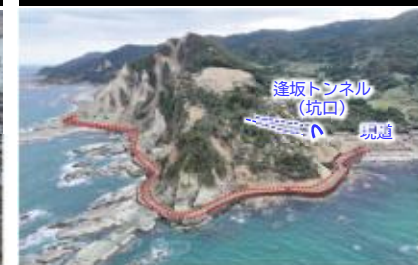
③逢坂トンネル工区
