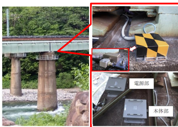
図12 対象橋脚およびシステム設置状況
