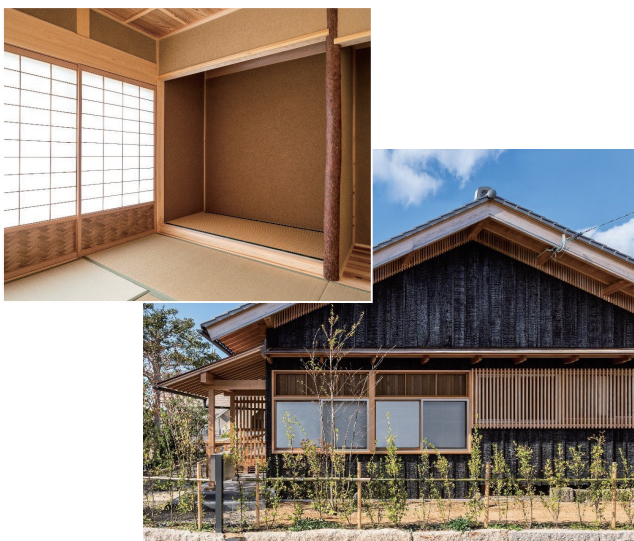
写真 2-4 片面真壁造の土塗壁
