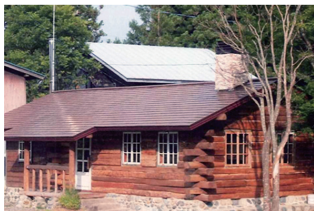
写真 3-5 丸太組構法 外部両面丸太現し（外部）
