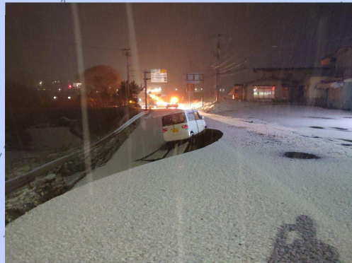
国道394号で発生した法面崩落の状況
