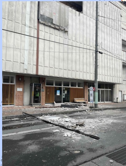
県道で発生した落下物（外壁剥落）の状況
