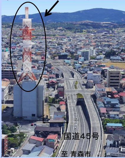
損傷が確認された沿道建築物
