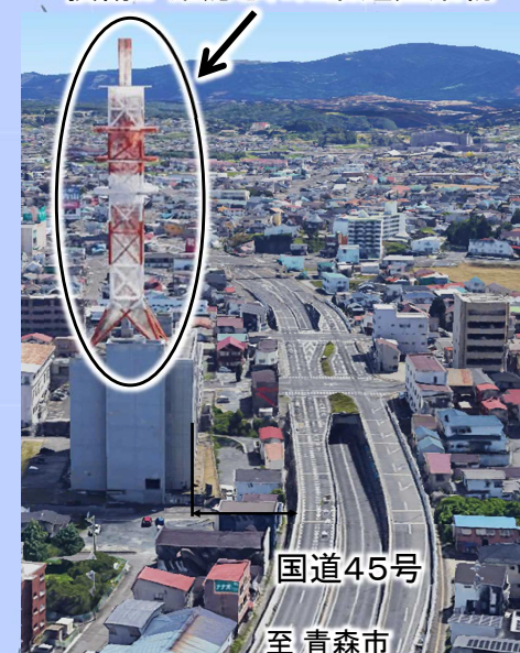
損傷が確認された沿道建築物
