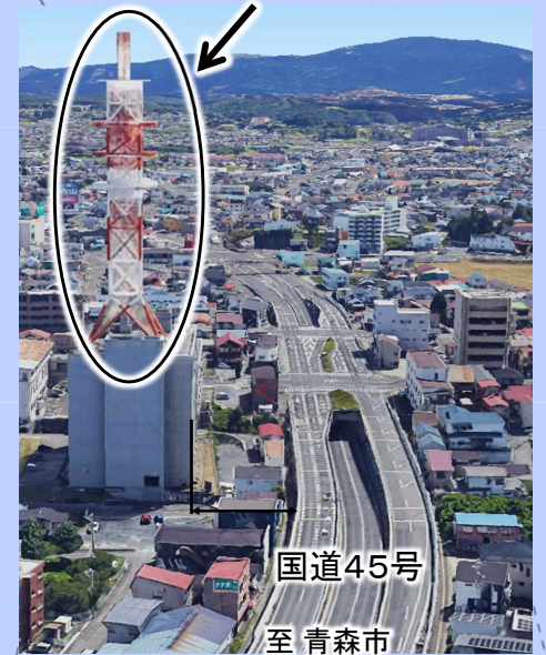
損傷が確認された沿道建築物
