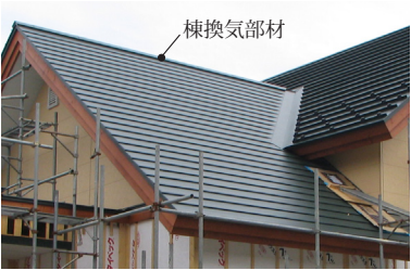
写真 5.1.5 棟換気併用軒天換気方式の例
