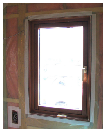
写真 5.6.1 開口部の気密化例
