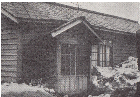
写真 2.1.1 凍上による被害
