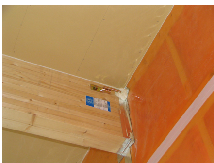
写真 5.5.1 柱下部が防湿フィルムを貫通する部分の施工例
