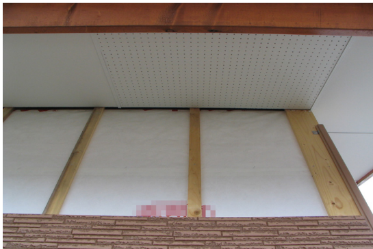
写真 5.1.3 縦胴縁と軒天部の納まり例
