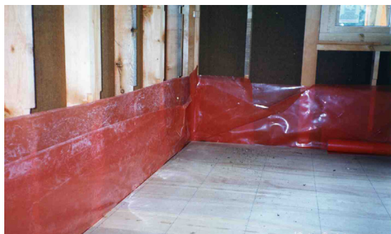
写真 5.2.1 先張り防湿フィルムの施工例
