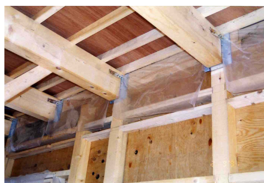
写真 5.2.3 先張り防湿フィルムの施工例 2
