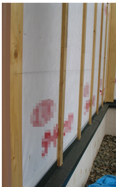
写真 3.2.5 透湿防水シートの施工例
