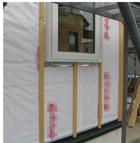
写真 5.1.4 縦胴縁による通気層の施工例
