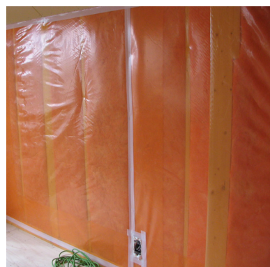
写真 3.2.2 防湿フィルムの施工例
