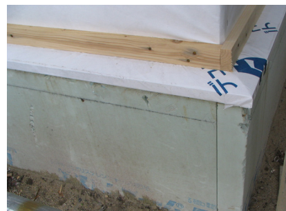
写真 5.1.2 基礎断熱の施工例
