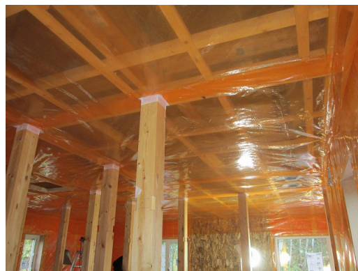
写真 5.2.4 天井の防湿フィルムの施工例
