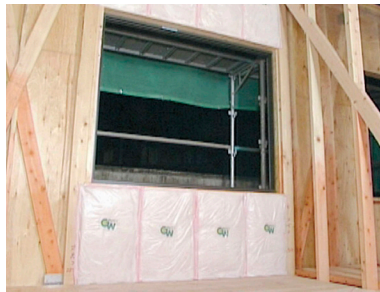
写真 5.4.1 開口部まわりの断熱施工
