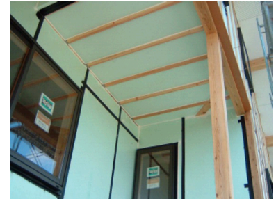
写真 5.2.7 外壁と軒天の断熱
