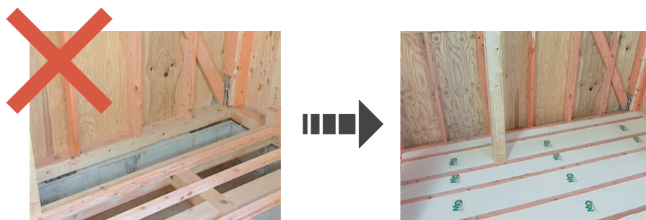
写真 5.2.3 押入れの床の断熱
