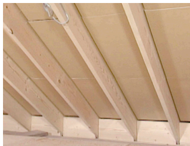
写真 5.6.2 屋根の通気層確保部材（板状）
