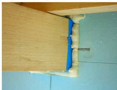
写真 5.3.5 貫通部の断熱補強
