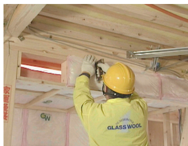
写真 5.7.3 下がり壁の断熱
