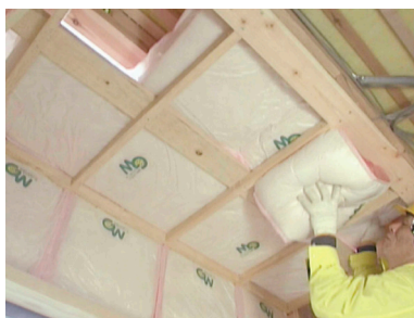
写真 5.7.2 下屋の天井断熱
