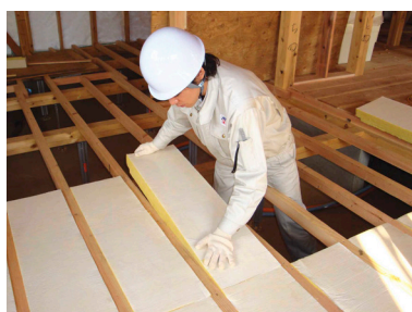
写真 5.2.1 断熱材の切断と施工
