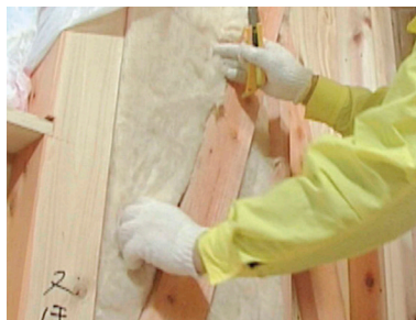
写真 5.3.4 筋かい部分の断熱材の施工
