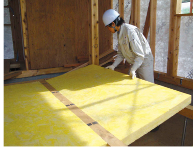
写真 5.2.2 断熱材受け専用金物
