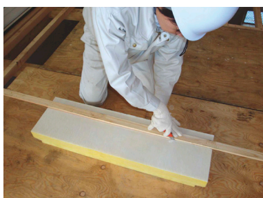
写真 5.2.1 断熱材の切断と施工
