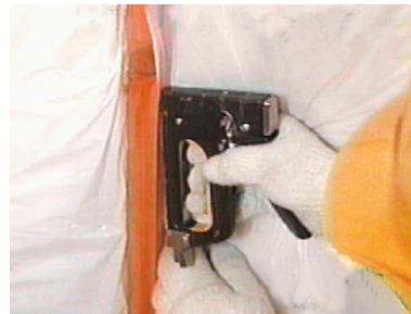
図 5.3.9 防湿フィルムの施工の悪い例 - 1
