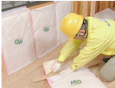
写真 5.3.1 繊維系断熱材の切断
