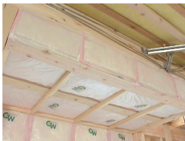
写真 5.7.4 断熱材の施工が完了
