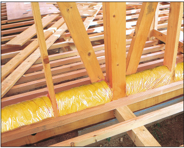
写真 5.2.6 間仕切り壁下の繊維系断熱材の気流止め
