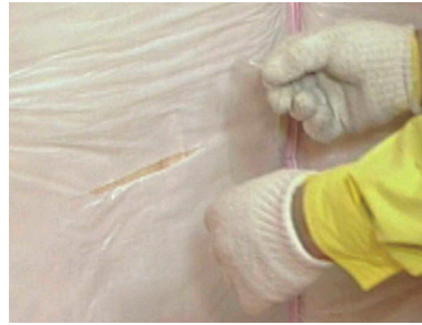
写真 5.3.3 防湿フィルムの補修
