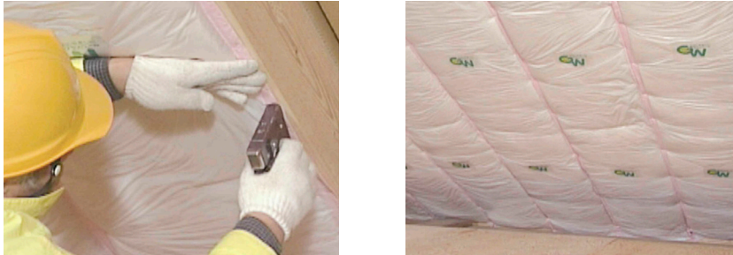
写真 5.6.1 屋根の充填断熱
