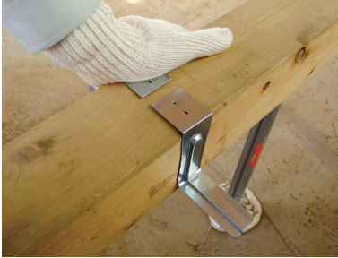
写真 5.2.2 断熱材受け専用金物
