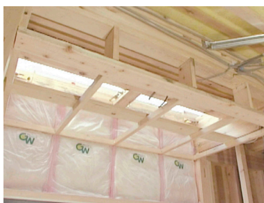
写真 5.7.1 下屋部分の断熱施工前
