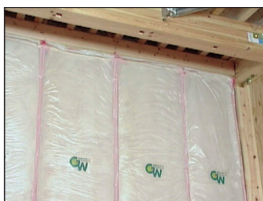
写真 5.3.2 繊維系断熱材の施工
