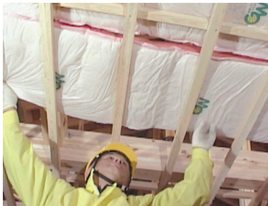
写真 5.5.2 天井の断熱材の施工
