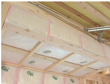
写真 4.2.5 断熱材の施工が完了
