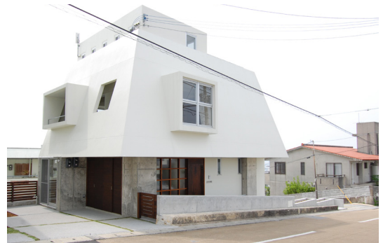
写真 3.6.4 屋根、壁面に遮熱塗料を塗布
