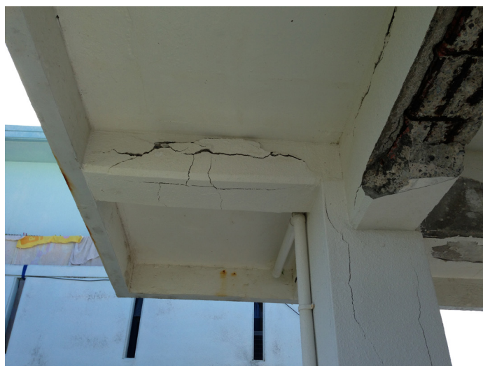
写真 2.2.7 コンクリートの劣化：剥離・剥落、鉄筋の断面欠損の状況 出典：平成 27 年風土に根ざした家づくり手引き書 沖縄県土木建築部住宅課 P24 より
