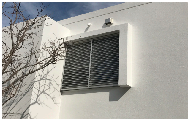
写真 2.2.5 台風対策を兼ねた開閉式ガラリ
