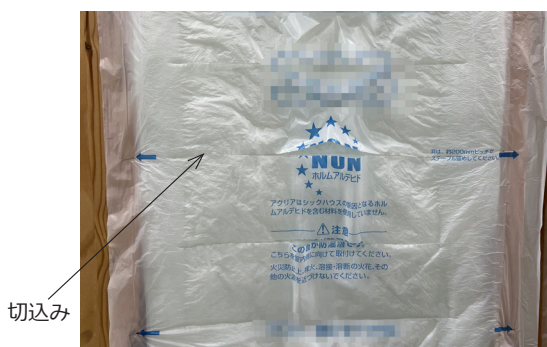
写真B 防湿フィルムの切込み加工を行った 外壁施工の例
