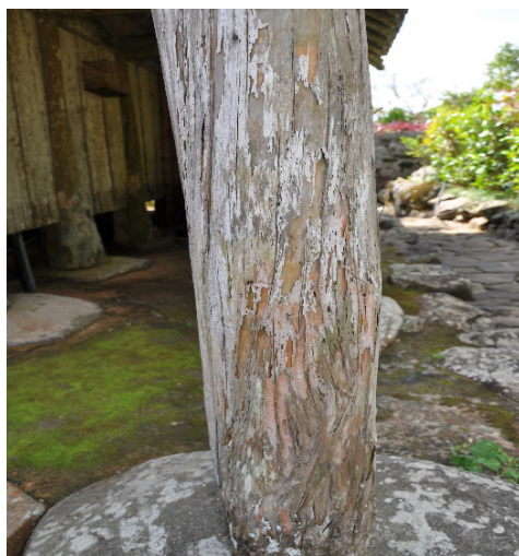
写真 2.2.10 ダイコクシロアリの被害
