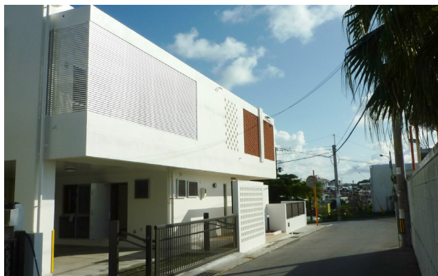
写真 2.2.3 通風・遮熱軽減・台風対策等を同時に行う ルーバー・花ブロックによる日射遮蔽の事例
