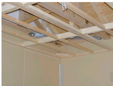
写真 4.2.4 天井の野縁の施工
