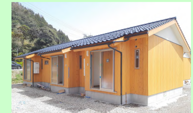
木造仮設住宅（輪島市完成例）
