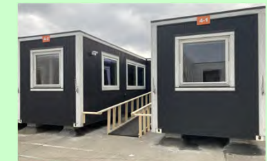
ムービングハウス（輪島市完成例）
