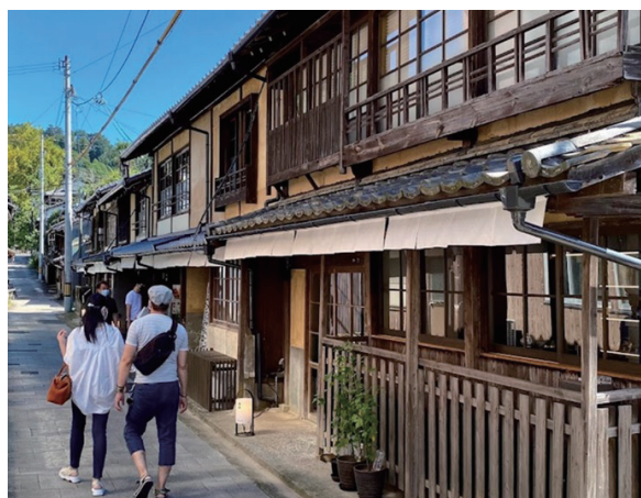
図表 134. 回遊性が生まれている様子(1階は店舗、2階が宿泊客室) 25
