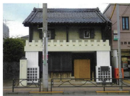
渡邊家(蔵) 外壁/床/耐震改修を実施
