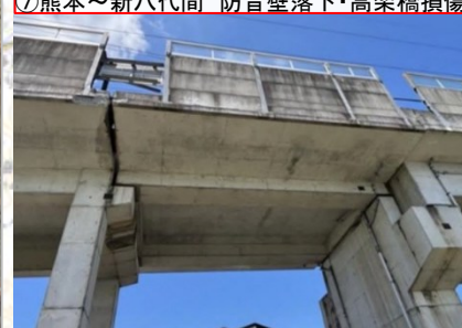
⑦熊本～新八代間 防音壁落下・高架橋損傷
