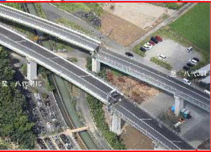
通行止め箇所(妙見第一橋 橋梁損傷) E3A南九州自動車道 (八代JCT~八代南IC間)
