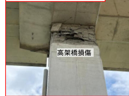
③熊本～新八代間 高架橋損傷
