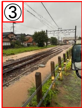
③ 能登部駅構内 線路冠水
