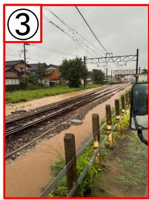
能登部駅構内 線路冠水
