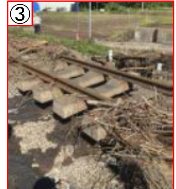
計石～牛ヶ原間 : 路盤流出
