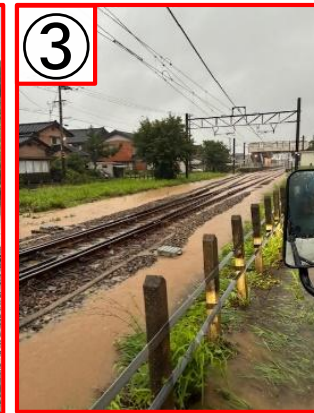
③ 能登部駅構内 線路冠水
