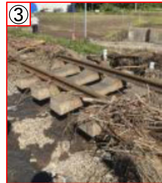
計石～牛ヶ原間 : 路盤流出
