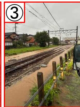
③ 能登部駅構内 線路冠水
