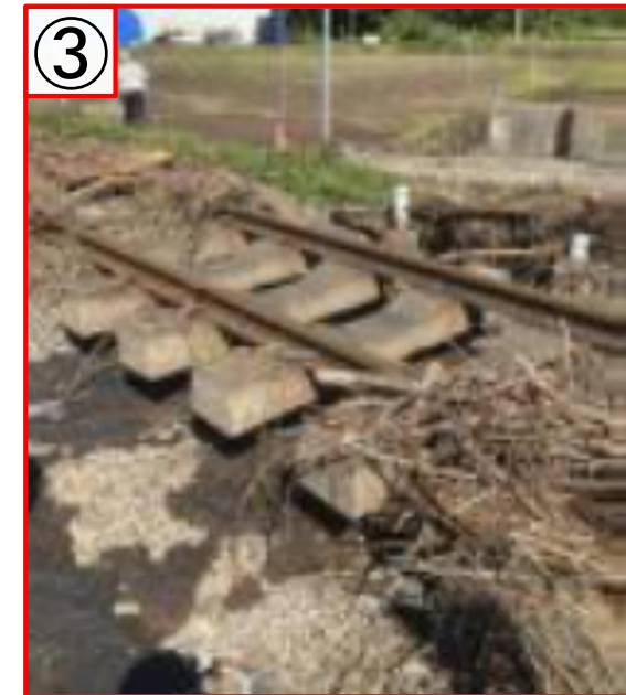
計石～牛ヶ原間 : 路盤流出
