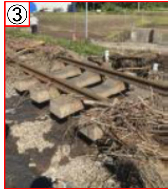
計石～牛ヶ原間 : 路盤流出
