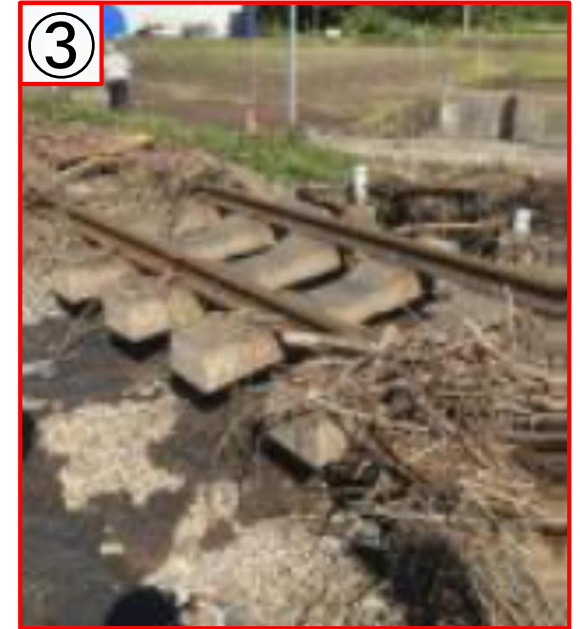
計石～牛ヶ原間 : 路盤流出
