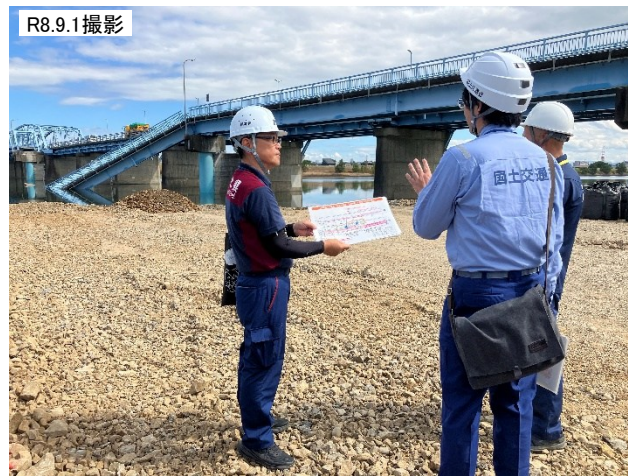
緊急調査状況（植柳橋）
