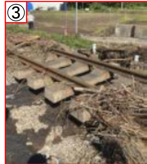
計石～牛ヶ原間 : 路盤流出
