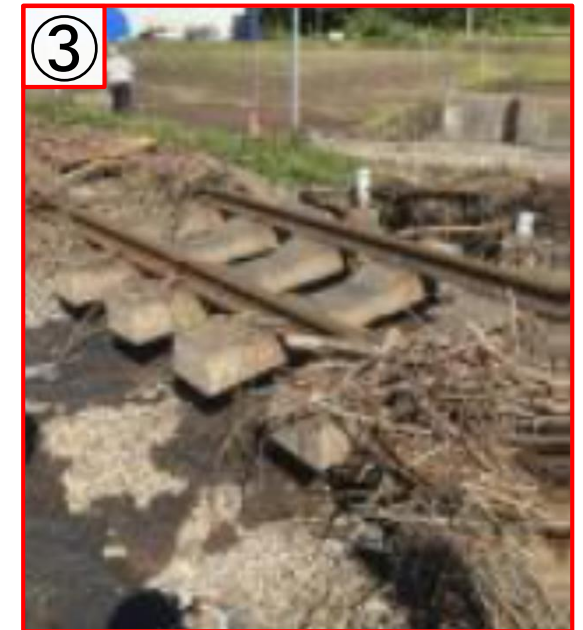
計石～牛ヶ原間 : 路盤流出
