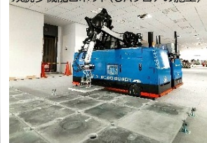
双腕多機能ロボット(OAフロアの施工)
