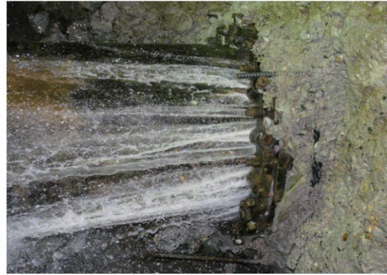
写真 4.28 配管継手部からの漏水状況
