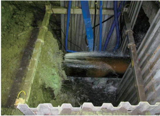
写真 4.28 配管継手部からの漏水状況
