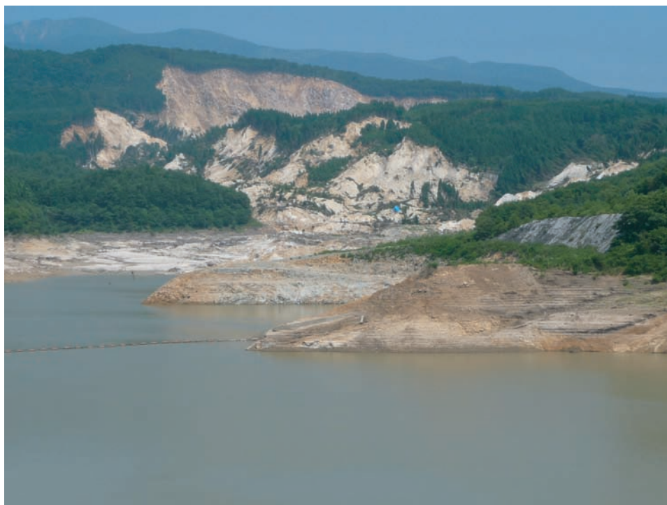
写真 4.8 荒砥沢ダム 上流部大規模地滑り箇所
