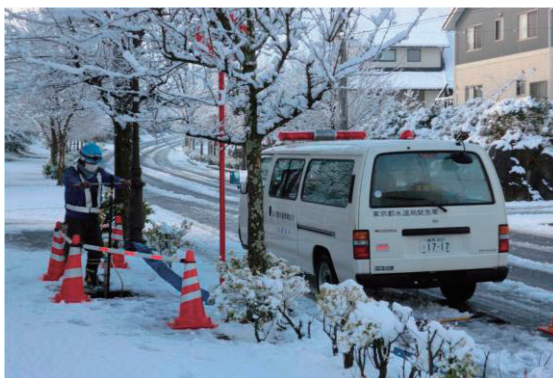
写真 1.2 仙台市内で通水に向けた排水作業を行う支援事業者
