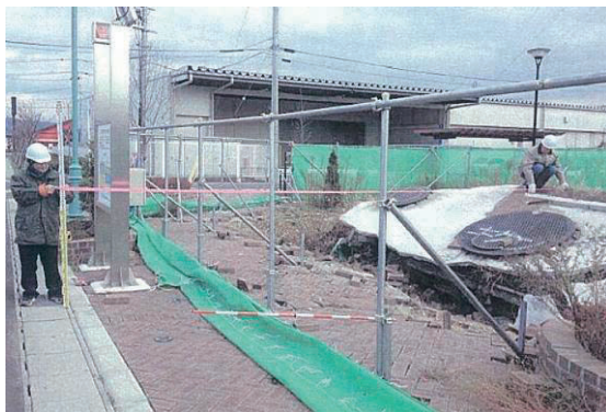
耐震貯水槽が 1.15m 隆起した
