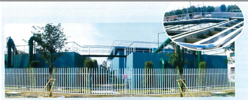
写真 1 和平鎮浄水場の外観
