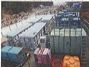
処理ユニットによる処理場と別位置での応急対応状況(陸前高田市)
