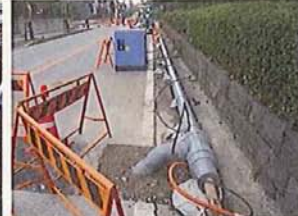
仮配管による応急復旧状況 (千葉県 習志野市)
