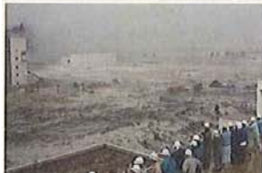
津波により浸水する下水処理場 (仙台市 南蒲生浄化センター)
