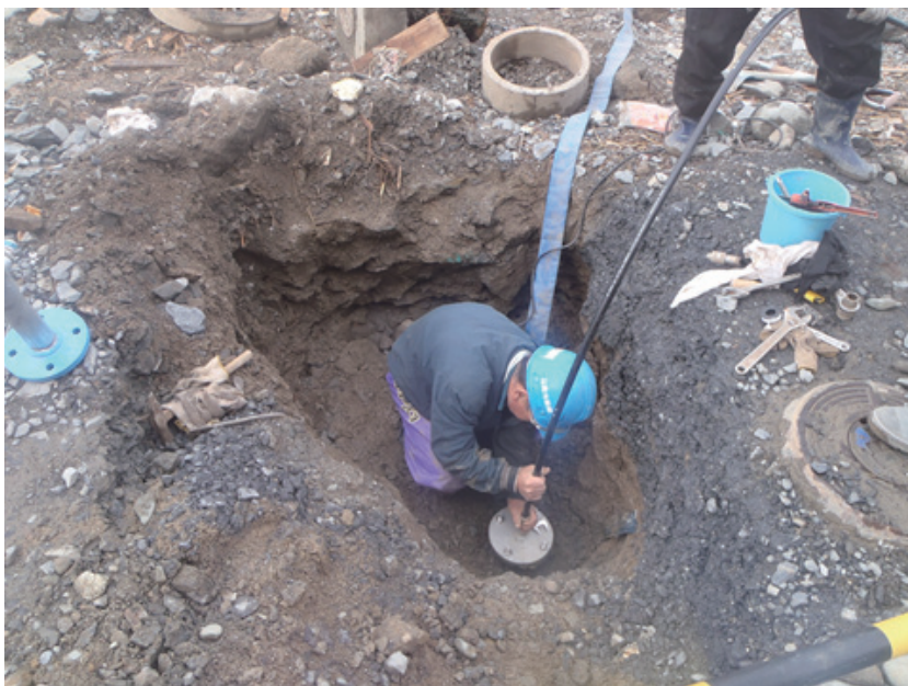
この写真は空気圧試験の様子です。
