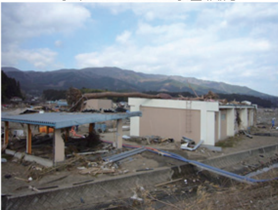
水中ポンプによる水替状況
