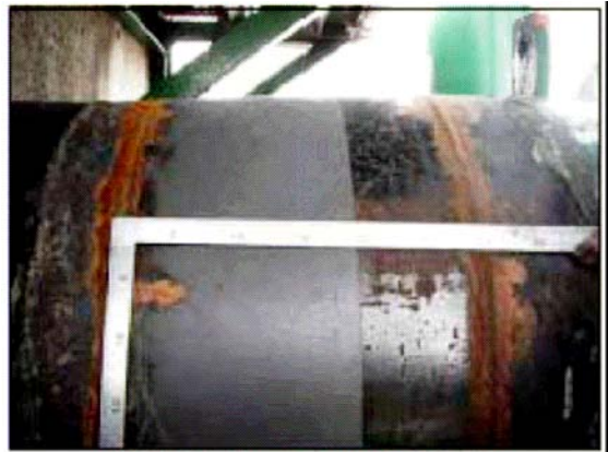
伸縮管を切断し、L=300の短管を溶接
