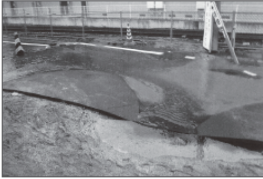
▲森合小松原地内山神系送水管 (DIPφ500mm) からの漏水状況 写真 4.135 送水管からの漏水状況
