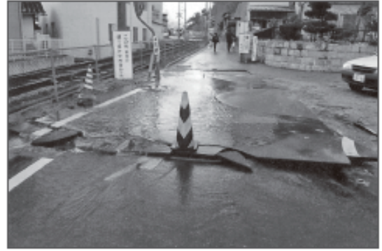
▲森合小松原地内山神系送水管 (DIPφ500mm) からの漏水状況 写真 4.135 送水管からの漏水状況
