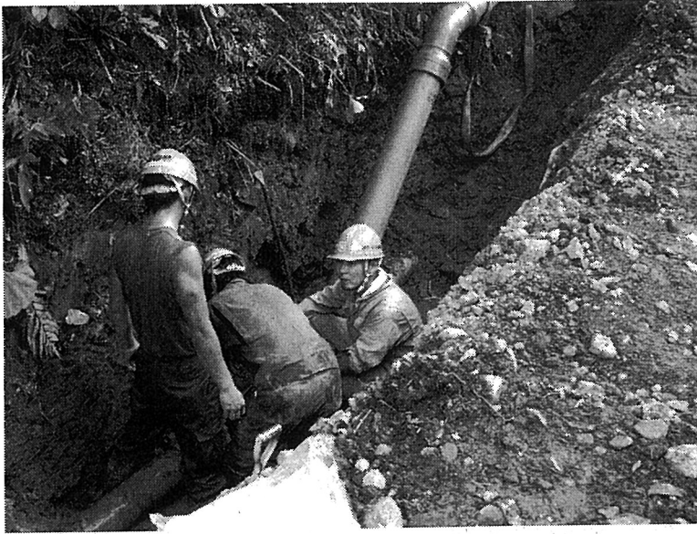
奥州市での復旧作業 (写真提供=日本水道協会)
