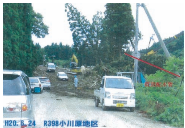
写真 4.14 道路寸断箇所の復旧工事 (浅布・小川原飲料水供給施設 赤いラインが既設配管)
