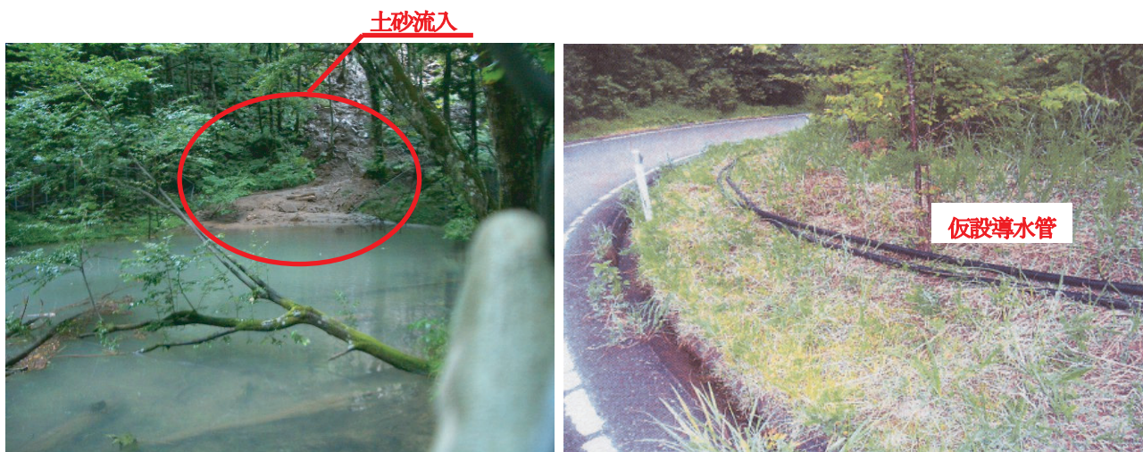
写真 4.9 土砂流入による水源地で濁り水発生と仮設導水管
