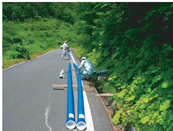
写真 3.4 緊急連絡管の布設 (小豆畑地区)
