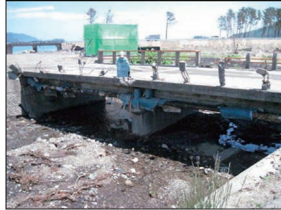
浪板橋水管橋 保温材復旧工 送水管 \phi 100 L=16.90m 配水管 \phi 100 L=16.90m
