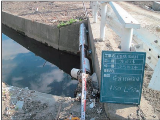
安渡 1 丁目水管橋 \phi 150 L=5.20m 保温材復旧工
