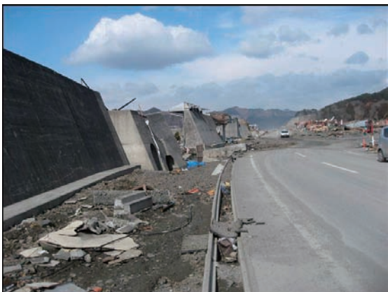
安渡3丁目護岸全景
