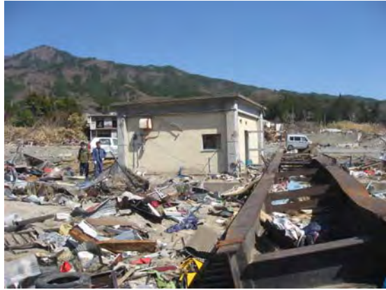
写真 3.5 津波による加圧ポンプ所の被災例（岩手県大槌町浪板ポンプ場）
