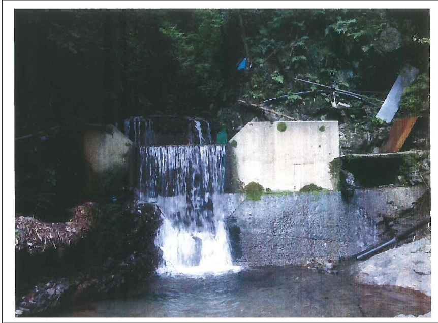
写真 5 k 地区取水施設
